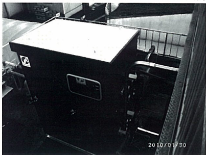
写真2 ナノピコ酸素排水処理システムの実例
